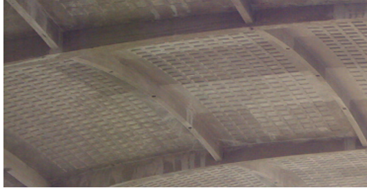
Figura 4. Cubierta tipo Bóveda en Concreto, sistema de membranas nervadas. Fuente: Guillermo González Zuleta & CIA. Estadio de Béisbol Mariano Ospina Pérez, Premio Nacional de Ingeniería (Cartagena, 1947).
