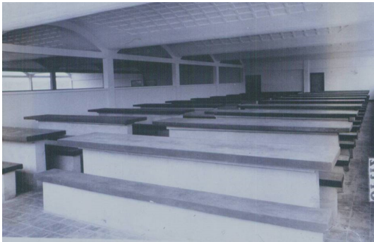
Figura 11. Bóveda Membrana de la Penitenciaría de Popayán (1952). Fuente: Guillermo González Zuleta & CIA
