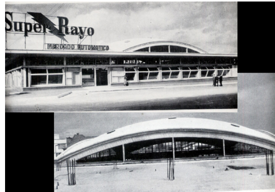
Figura 17. Membrana de Doble Curvatura, Supermercado Rayo (Bogotá, 1955). Fuente: Guillermo González Zuleta & CIA
