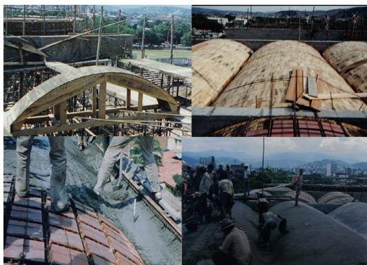
Figura 24. Proceso constructivo Cubierta en Membrana de Concreto, Estadio General Santander (Cúcuta, 1983). Fuente: Guillermo González Zuleta & CIA
