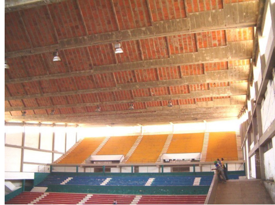
Figura 22. Bóvedas Plegadas, Coliseo Humberto Perea (Barranquilla, 1961). Fuente: Guillermo González Zuleta & CIA
