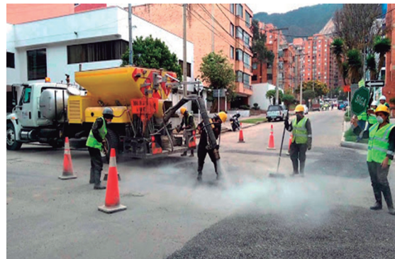
Figura 2 Método inyección a presión neumática mezcla asfáltica en frío Fuente: Archivos Unidad Mantenimiento Vial Bogotá Cll 127A por Cr 7
