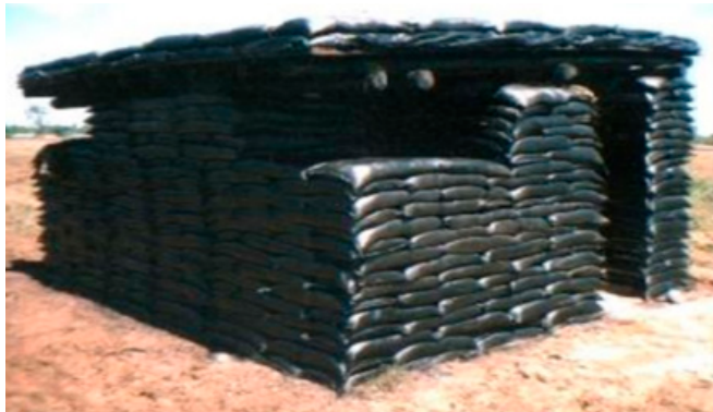
Figura 3. Posición para tirador doble. Fuente: Manual de Fortificaciones y Obstáculos EJC 3-115-1 del 2010 [7].
