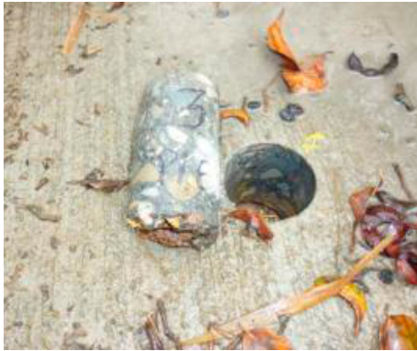
Figura 4. Extracción núcleos de concreto y ensayo de compresión simple. Fuente: autores del proyecto.
