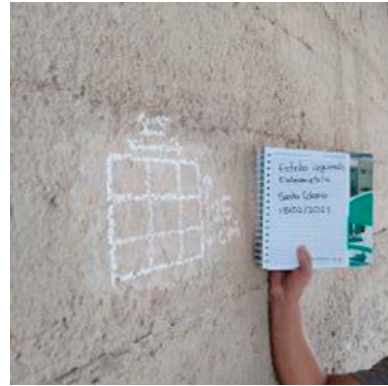
Figura 5. Ejecución en el puente de ensayo de índice de rebote. Fuente: autores del proyecto.
